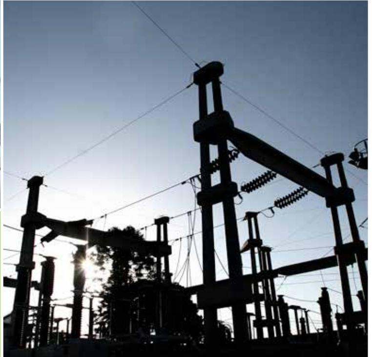
Construcción de una Estación Transformadora completa, cuadro de estación de 1 Ha, 2 campos de línea de 132 kV, 1 Transformador 132/33/13,2 kV - 15/10/15 MVA con campos de 132 y 13,2 kV equipados, edificio, etc.
