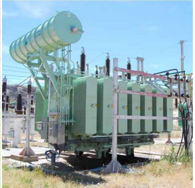
ET de 132/33/13,2 KV se ejecutará en la ET Jacobacci, con transformador de rebaje de 20 MVA. Se construirá un campo de transformación en 132 KV/33/13,2 KV y se ampliará la barra de 33 KV, de manera que permita el ingreso de este nuevo campo.
