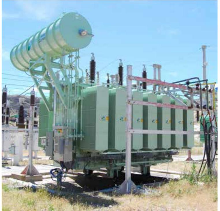
Se deberá construir en la localidad de El Solito una E.T. de rebaje de 132/33/13,2 KV que contará con la instalación de un transformador de 15 MVA en 13,2 KV.
