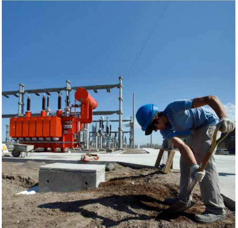
Construcción nueva Estación Transformadora de 132 kV. Constará de un predio de 100 mts x 100 mts (10.000 m<sup>2</sup>), con dos campos de 132 KV de entrada y salida de línea, dos barras de 132 KV (principal y transferencia), un campo de transferencia en 132 KV, un campo de transformación de 132/33/13,2 KV 30/30/30 MVA, 3 celdas de 33 KV, y 6 celdas de 13,2 KV.
